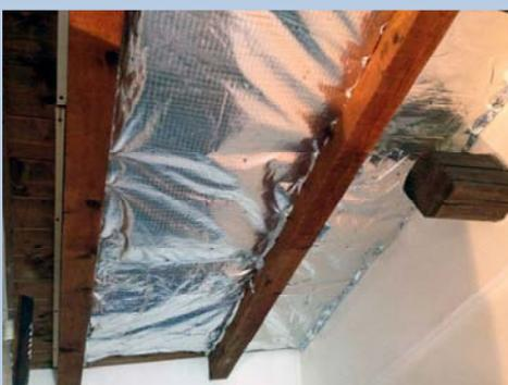
Fissaggio dell'isolante Over-foil Multistrato 19 ai listelli di legno
